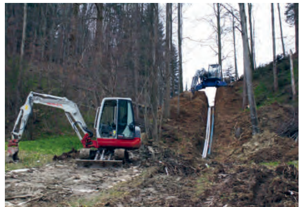
Leitungsbau oberhalb des Schmittli: 2012 baute die WGA eine Leitung nach Neuägeri, um über den neu erstellten Betriebschacht Schmittli den Verbund mit der Wasserversorgung Unterägeri (Korporation Unterägeri) zu realisieren (Aufnahme vom 30. März 2012).
